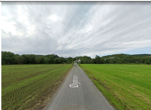
Bilde fra Øynoveien, mot brua over elva Sokna. Gående kan skimtes i veikanten. Kilde: Google Streetview
