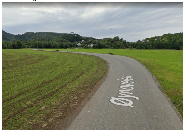
Bilde fra Øynoveien, mot elva Sokna. Trafikksikker løsning for mange trafikanter er tiltenkt på venstre siden av dagens kjørevei. Kilde: Google Streetview
