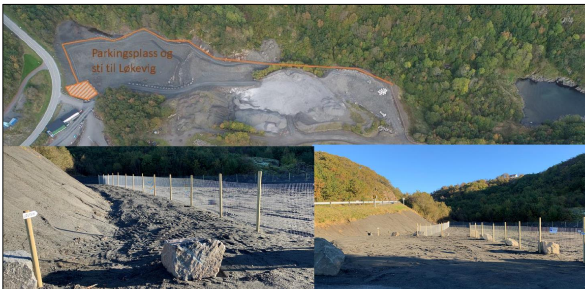
Figur 17: Parkeringsplass og sti til Løgevig
