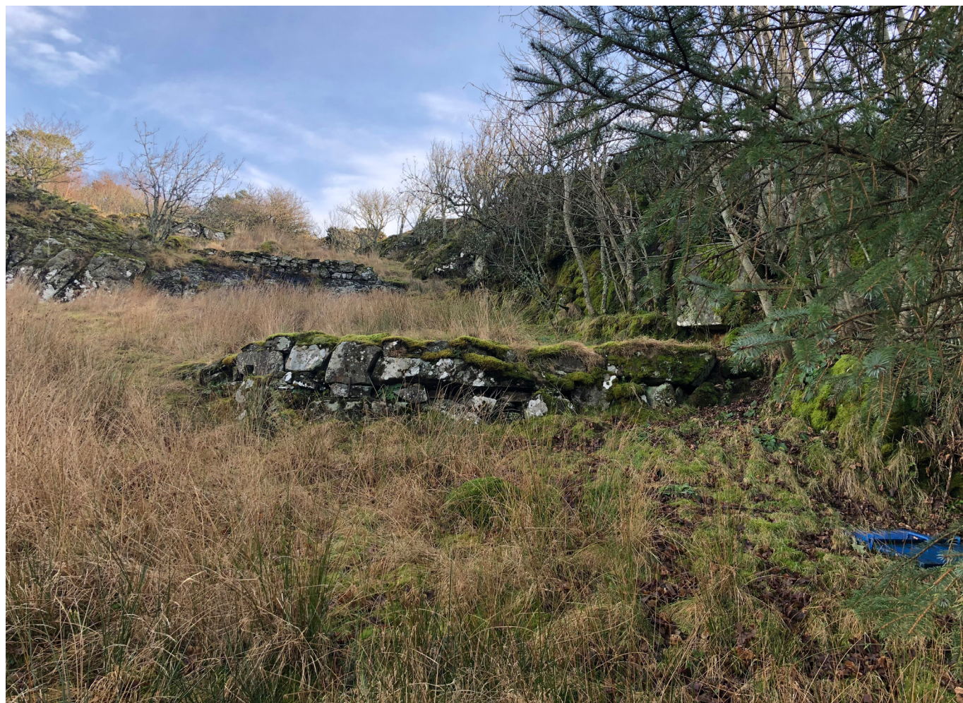
Figur 6-5 Bakkemur på tomt 75. Posisjon av brønn synlig til høyre.
