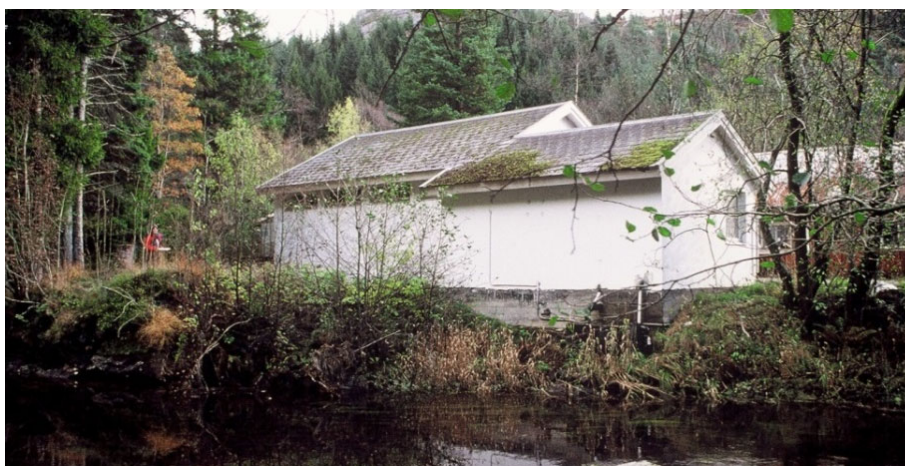
Figur 10: Eksisterende bygning i BN6 er den gamle brannstasjonen. Bygningen er i dag utleid til annen virksomhet. Bygningen ligger tett på elvekanten. Foto: Harald Hognerud, Dalane Folkemuseum, hentet fra bøkene Gruvedrift i Sokndal gjennom 140 år .
