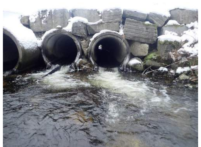
Figur 27. Øverst: Rennen ned mot utløpet til Øvra Hellvikvatnet. Legg merke til all den tilførte finkornete grusen i elvebunnen. Midten: Grustaket/deponiet som grusen stammer fra. Nederst: Det øverste strykpartiet med en slags terskel og kulvert under Maurholsveien.
