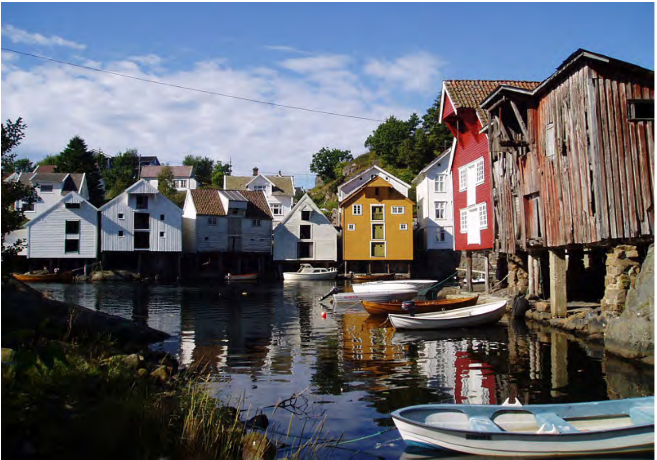
Sjøhus før ombygging. © Kjell Andresen, Riksantikvaren.
