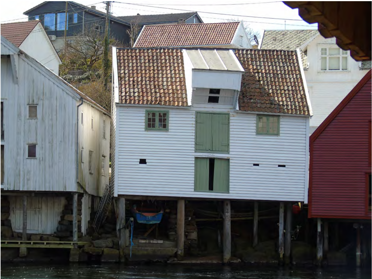
Sjøhus med båt heist opp under bjelkelaget. Foto: Solveig Roti Dahl, RFK.
