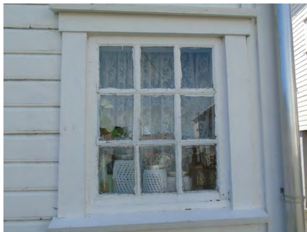
Bildet øverst: Ulike beslag på samme vindu. Bilde under: Fast vindu, kan ikke åpnes. Foto: Solveig Roti Dahl, RFK.
