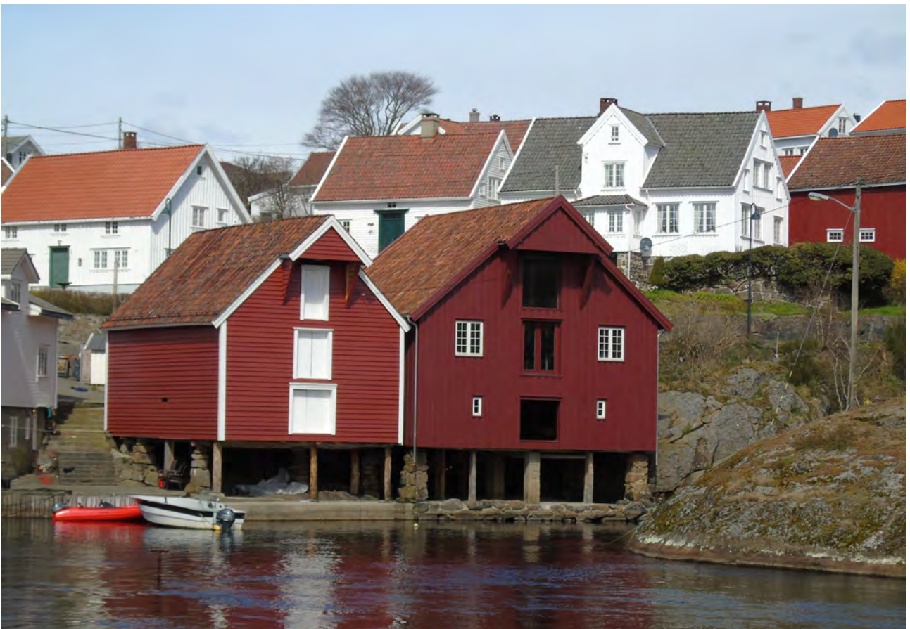
Sjøhus tilbakeført til opprinnelig form. Foto: Solveig Roti Dahl, RFK.
