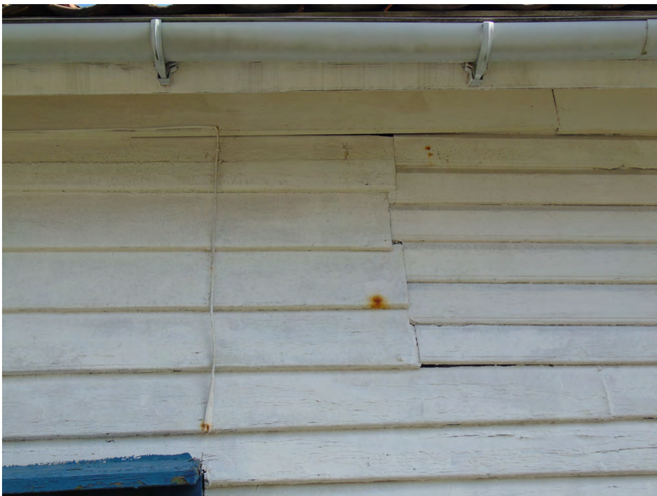
Eksempel på reparasjon med ulik type panel, som får frem noe av historien til bygningen. Foto: Solveig Roti Dahl, RFK.
