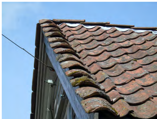
Takpanner som går utenfor gavl (trolig ikke en spesielt vanlig løsning. Foto: Solveig Roti Dahl, RFK.
