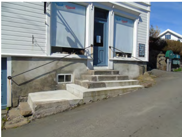
Trapp reparert med samme material kun der det var behov. Foto: Solveig Roti Dahl, RFK.
