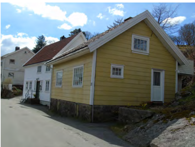
Strandgata 17. Huset har uendret hovedform og taktekkning, men kledning og vinduer er sterkt endret. Eventuell tilbakeføring kan vurderes, men krever dispensasjon. Foto: Solveig Roti Dahl, RFK.
